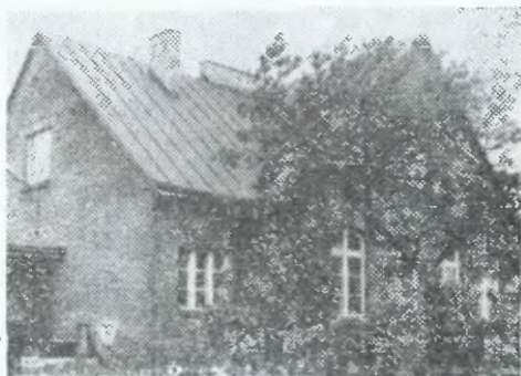
Ryc. 6. Stary budynek szkolny.
