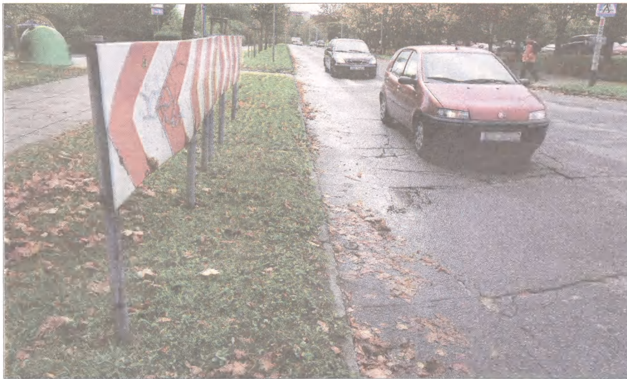
Kierowcy muszą uzbroić się w cierpliwość. Poczekają jeszcze na zakończenie remontu ulicy Małcużyńskiego, która w związku z budową miejskiego ringu jest mocno obciążona ruchem pojazdów.
