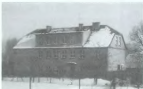
Fot. 22 Budynek szkolny w Bojanie po ostatniej rozbudowie w 1974 r.
