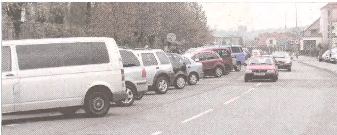
Po 9 czerwca będzie wiadmo, czy ulica Gdańska w Bytowie zostanie w tym roku zmodernizowana.
