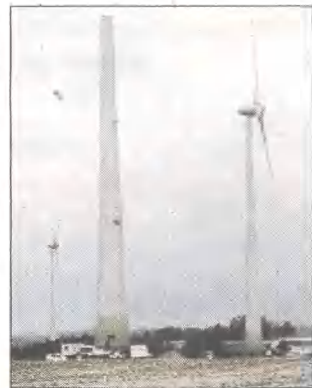
Montaż nowych wiatraków rozpoczęto w marcu bieżącego roku, zakończenie robót przewidziano na końcówkę września.
