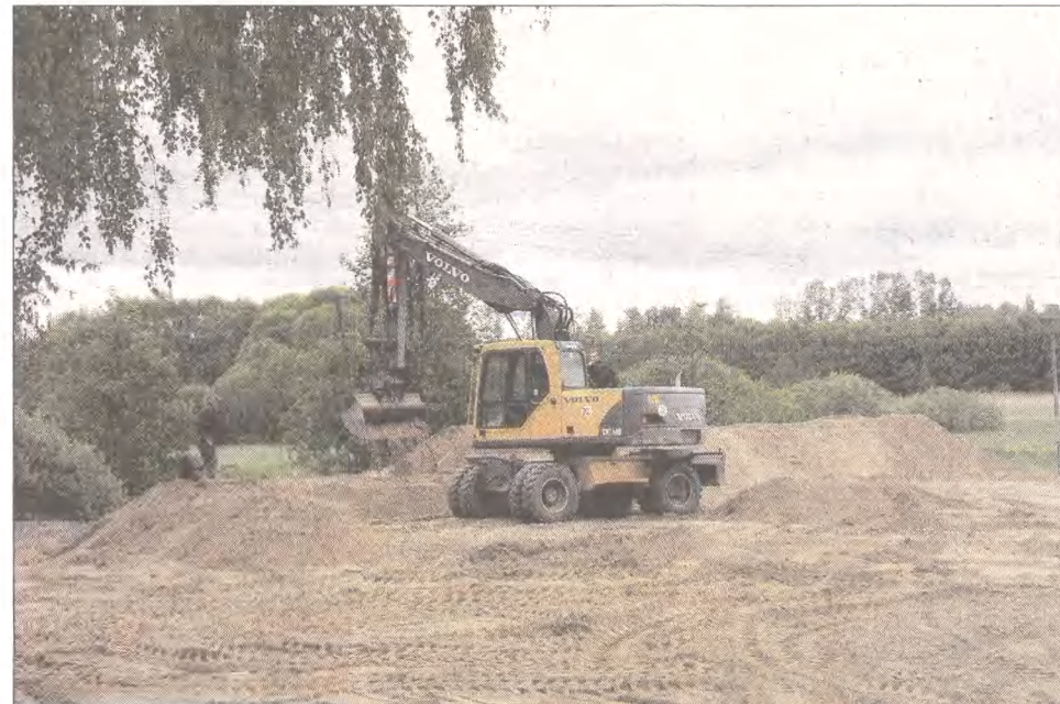
Prace ziemne przy budowie skateparku.
