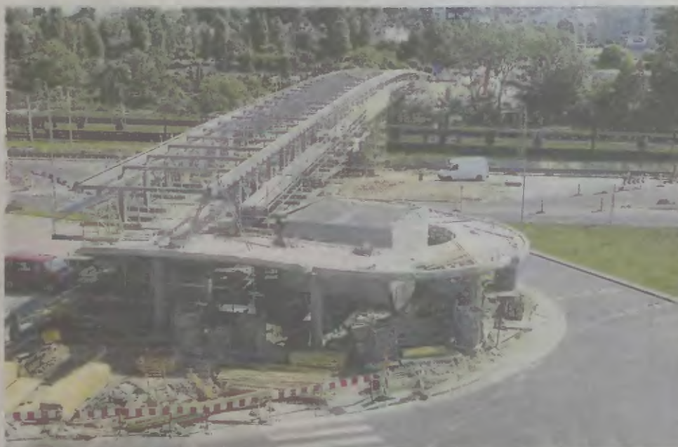
Kładka do użytku oddana zostanie w październiku po procedurach odbioru
