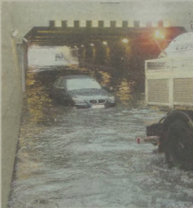
Sopocki tunel podczas niedawnej ulewy
