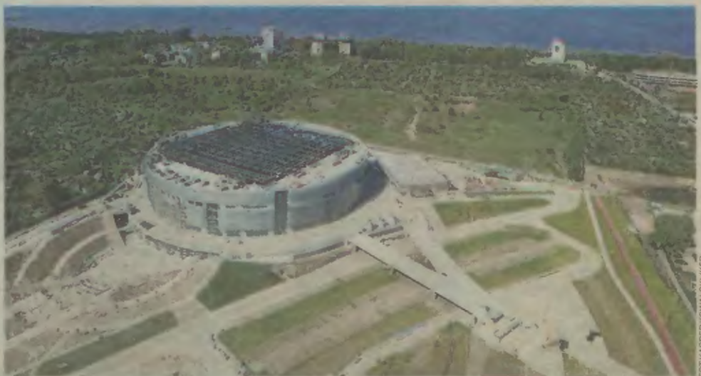
Parking, który powstanie przed halą, pomieści 1,8 tys. samochodów
