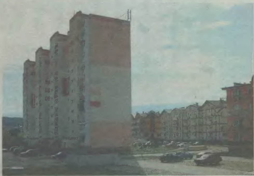
Anteny na bloku przy ul. Krakowskiej zaniepokoiły mieszkańców Janowa
