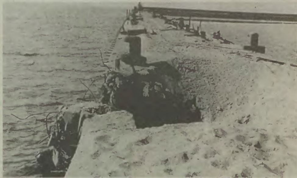
Uszkodzenia w zbombardowanym przez Niemców molu w porcie wojennym w Helu
