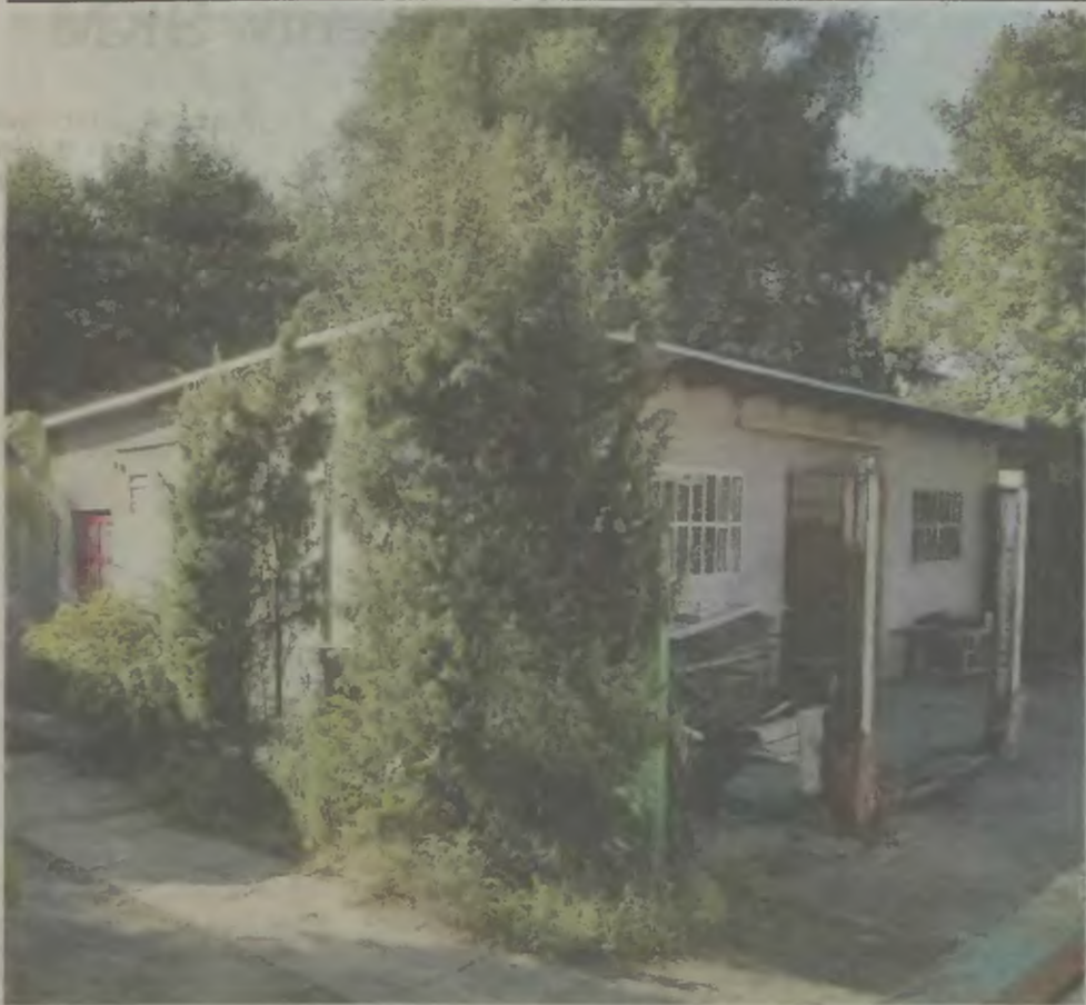
Słowackiego 32 A. Budynek mieszkalny już wyburzono, teraz czas na warsztat
