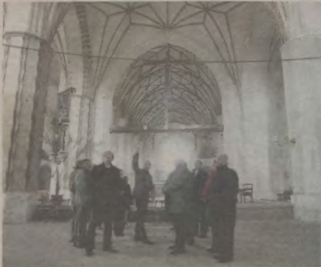
Radni sprawdzili postępy prac renowacyjnych w kościołach
