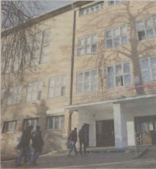
W budynku ZS nr 1 zamontowane zostaną kolektory słoneczne
