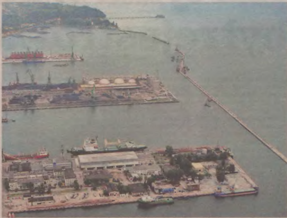
Rozbudowa falochronu w Gdyni trwa. Marinę udało się już jednak zabezpieczyć
