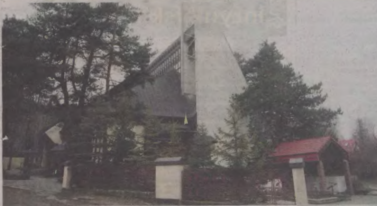
A tak wygląda ten sam kościół dziś. Podczas przebudowy powstała dwupoziomowa tylna część świątyni i nowa wieża
