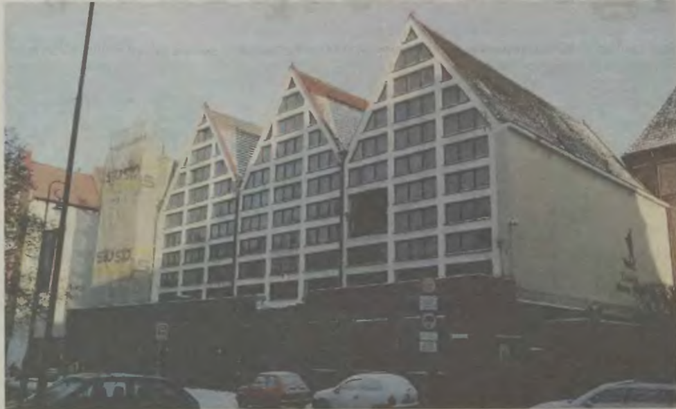
Prace rozbiórkowe Składu Kolonialnego CMM odbywają się bez wstrząsów
