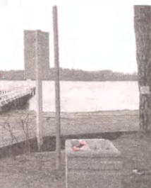
► Trwa remont pomostów nad jeziorem Jeleń. Roboty pochłonię ponad 50 tys. zł
