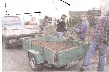
► Wyremontowano ponad kilometr dróg gruntowych systemem gospodarczym
