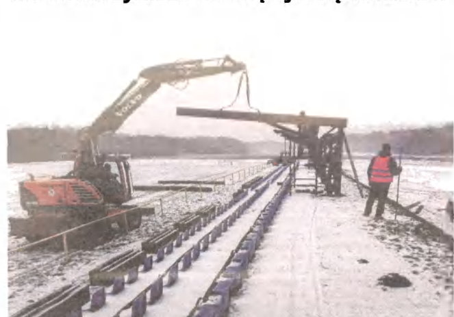
► W naszym regionie zmienia się baza sportowa. W wielu miejscowościach stadiony stają się coraz bardziej funkcjonalne, bo są sukcesywnie modernizowane. Tak na przykład jest w Trzebiele. Mimo zimowych warunków na stadionie trwają prace związane z postawieniem zadaszenia na sto miejsc siedzących. W razie deszczowej aury kibice będą mieli dobre warunki do oglądania meczów. ● (FEN)
