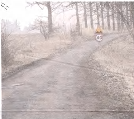
► Niedługo rozpocznie się modernizacja odcinka drogi powiatowej w Udorpiu
