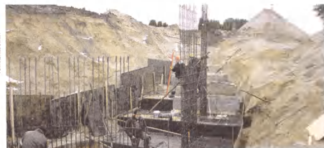
► Schody odchodzące od grotu w kierunku placu przed kościołem. Z drugiej strony wykonane zostaną takie same schody
