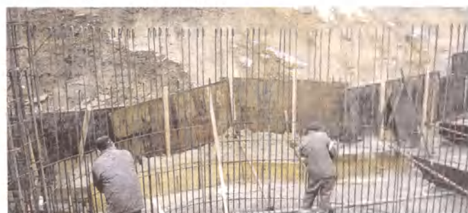
► W tym miejscu powstanie grota przy kościele w Zapcieniu. Jak widać, potrzebne jest na nią dużo stali
