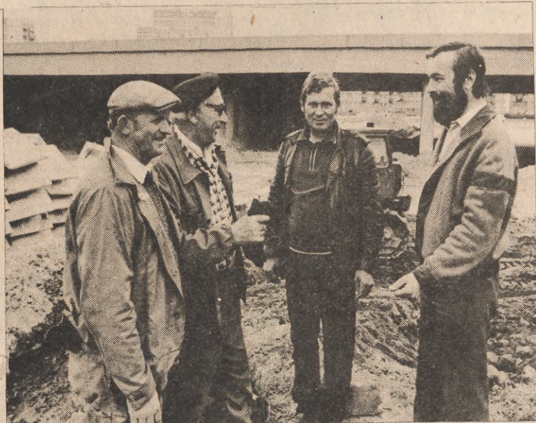
Na zdjęciu od prawej: kierownik budowy Krystian Szulc, operator koparko- Witold Rejowski, operator spychacza Henryk Rybarczyk i brukarz Antoni Ciszewski.
