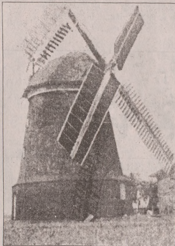
Taki wiatrak typu holenderskiego (z obracaną głowicą) stał we Włynkowie pod Słupskiem
