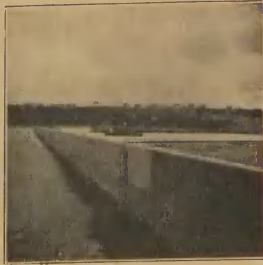
Ryc. 10. 2 \frac{1}{2} -metrowa nadbudówka betonowa, jaką otrzymują skrzynie po wypełnieniu piaskiem.
