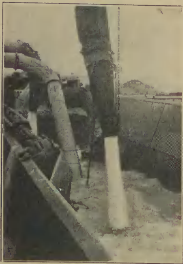
Ryc. 14. Piasek, uzyskany przez pogłębienie basenu węglowego, jest rozpuszczony i wessany przez drogę ssącą.
