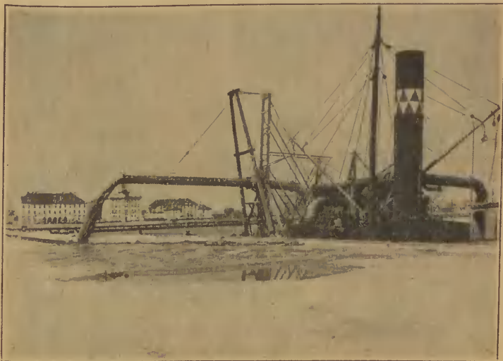
Ryc. 13. Czynność zarefulowania mola ujętego w ramę nabrzeży. Draga ssąca wylewa na molo piasek zmieszany z wodą.
