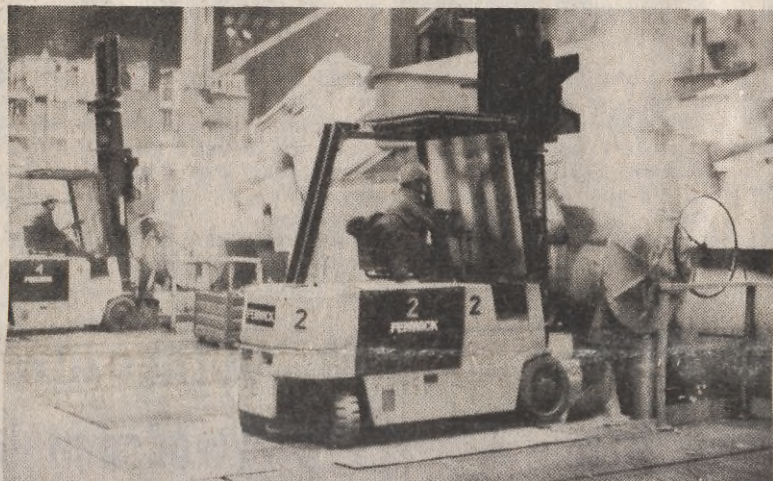
18 i 19 bm. w Zakładach Metalurgicznych „Ursus” w Lublinie zostały przekazane do eksploatacji: piec łukowy i indukcyjny. Jest to 3 zespół pracujący w tych zakładach. Tym samym zakończono 75 proc. budowy I etapu odlewni żeliwa. Na zdjęciu: pierwszy spust żeliwa z pieca indukcyjnego. CAF — M. Trembecki — telefoto
