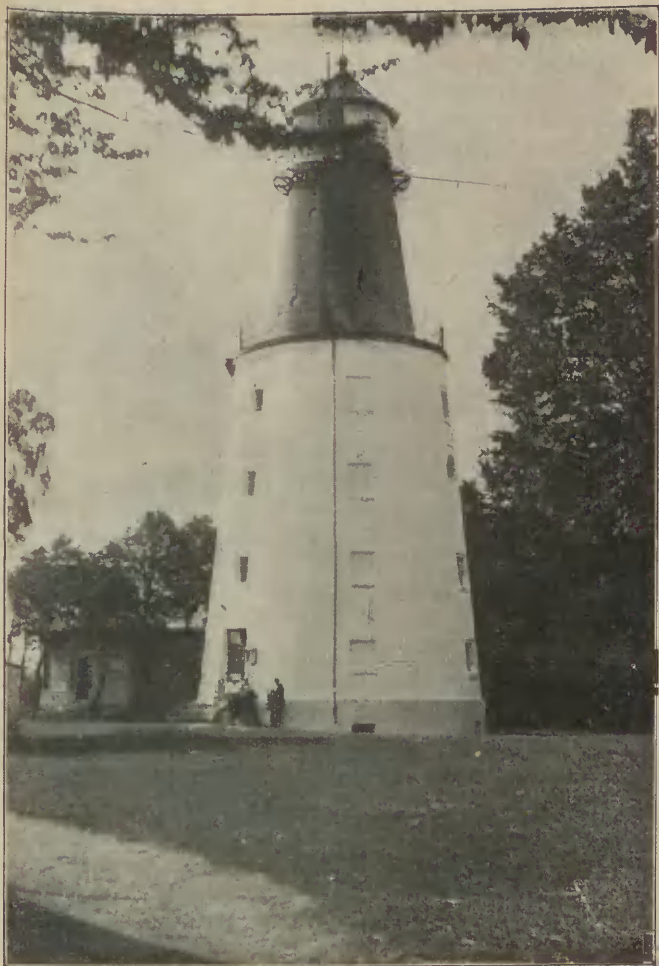
Latarnia morska w Rozewiu.
