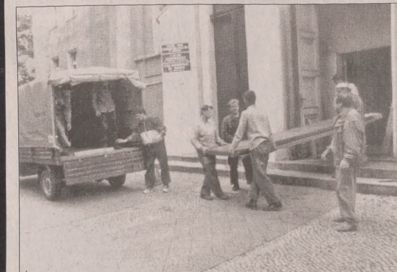
Pięciu mocnych ludzi było potrzeba do zdjęcia i ustawienia w samochodzie potowy drzwi wejściowych z gmachu słupskiego I LO przeznaczonych do naprawy.
