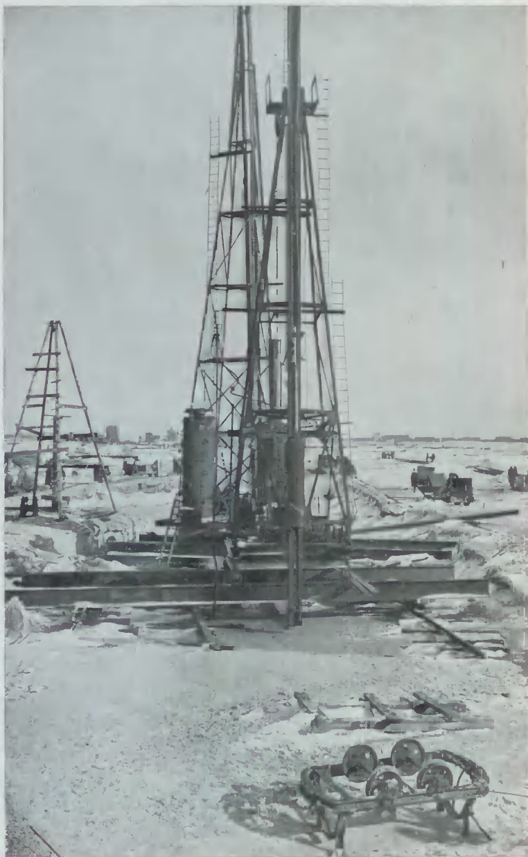
Rozpoczęcie budowy mostu kolejowego przez rzekę Prosnę na linii kolejowej Kalety — Podzamcze
