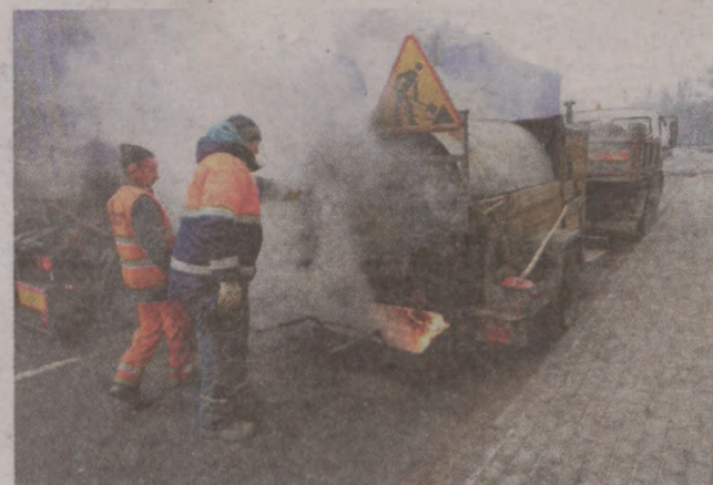
Wczoraj drogowcy łatali dziury w asfalcie między innymi na ulicy Garncarskiej w Słupsku
