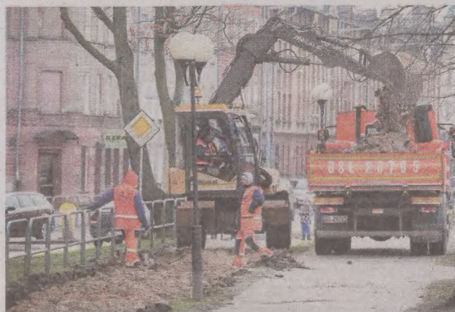
► Wczoraj zaczęły się prace przy budowie nowej ścieżki rowerowej. Będzie asfaltowa na ulicy Kołłątaja
