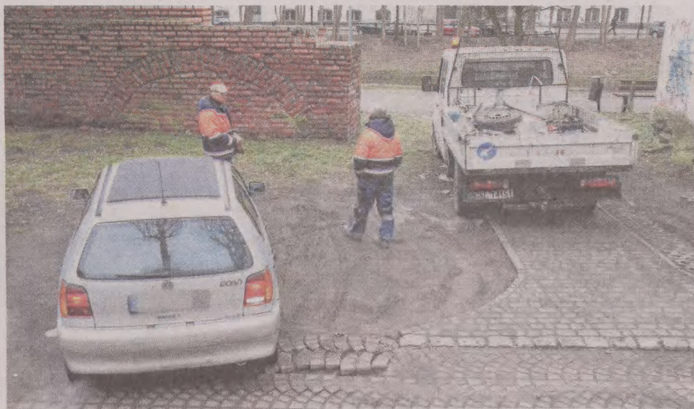
► Fragment ulicy Francesco Nullo, mimo że zaledwie kilka lat temu był jej remont, jest już zniszczony. Zarząd Infrastruktury Miejskiej zapowiada, że to miejsce zostanie naprawione
