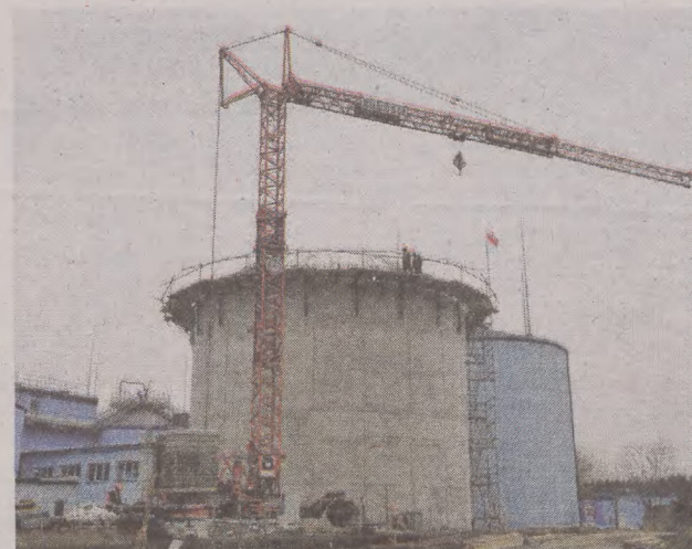
Budowa czwartej komory fermentacyjnej – koniec stycznia 2015 r.
