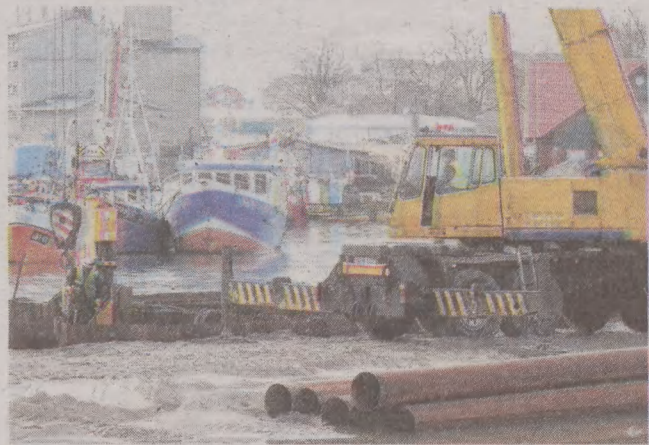
Roboty przy budowie nowego basenu w usteckim porcie mają się zakończyć w lipcu tego roku
