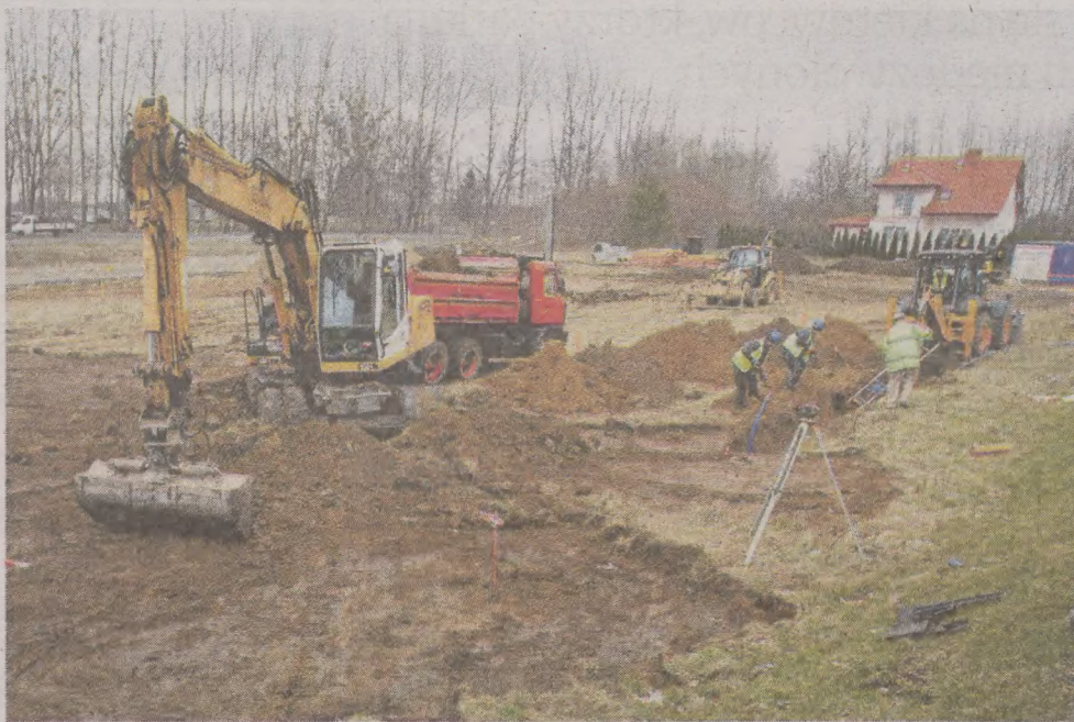
Nowa stacja paliw z budynkiem handlowo-usługowym przy ul. Szafranka mają powstać do końca maja. Są budowane w sąsiedztwie osiedla domków jednorodzinnych
