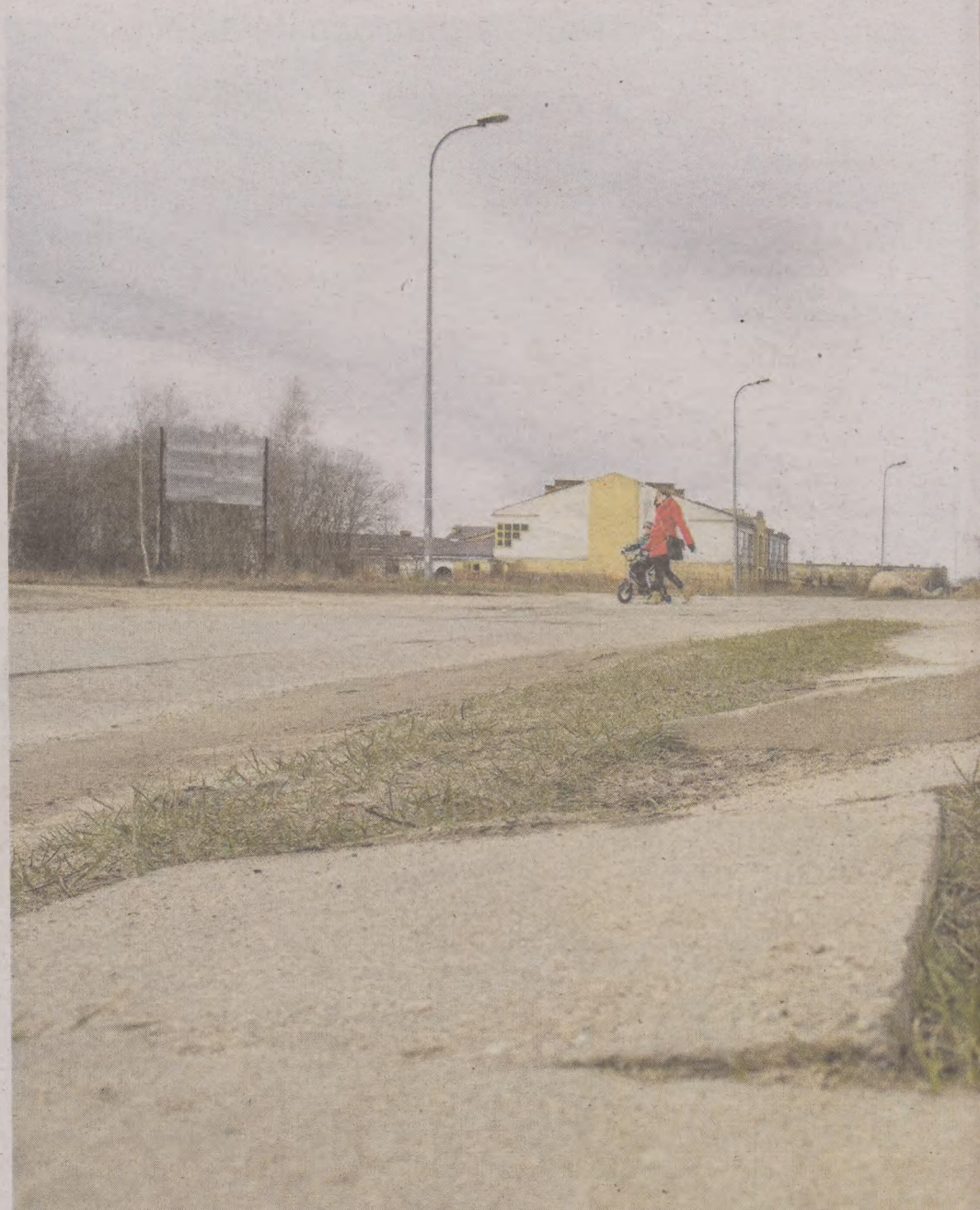
● Stan ulic na osiedlu Westerplatte-Hubalczyków pozostawia wiele do życzenia
