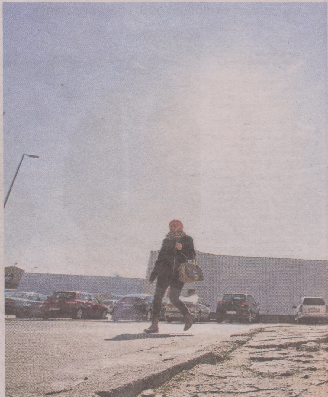
▶ Stan osiedlowych uliczek na Zatorzu pozostawia wiele do życzenia. Miasto ma pieniądze na bieżące utrzymanie
