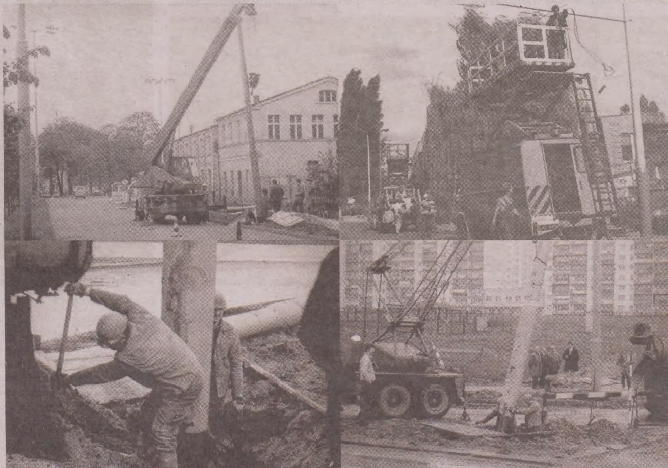
► Tak budowano w Słupsku trójkę trolejbusową. Tempo było ekspresowe - pierwszą linię zrealizowano w cztery miesiące
