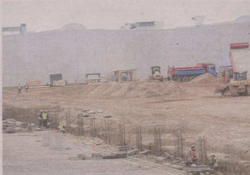
► Drugi etap budowy Europejskiego Centrum Stolarki w Bytowie będzie kosztował 100 milionów złotych. Nowa hala oznacza podwojenie produkcji i zatrudnienie kilkuset nowych osób
