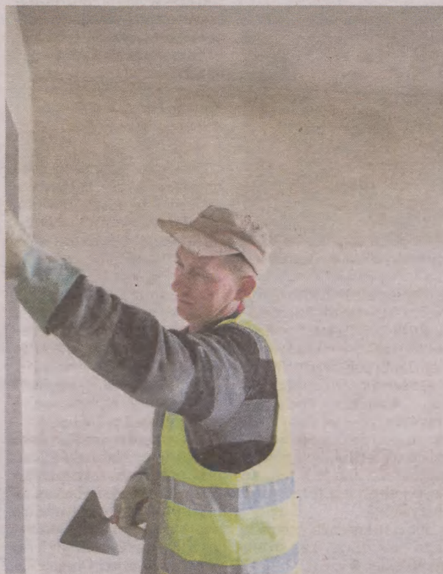
► Wewnątrz budynku przy ul. Szafranka 18 trwają już prace tynkarskie. Głównym wykonawcą jest spółka Arkom ze Słupska
