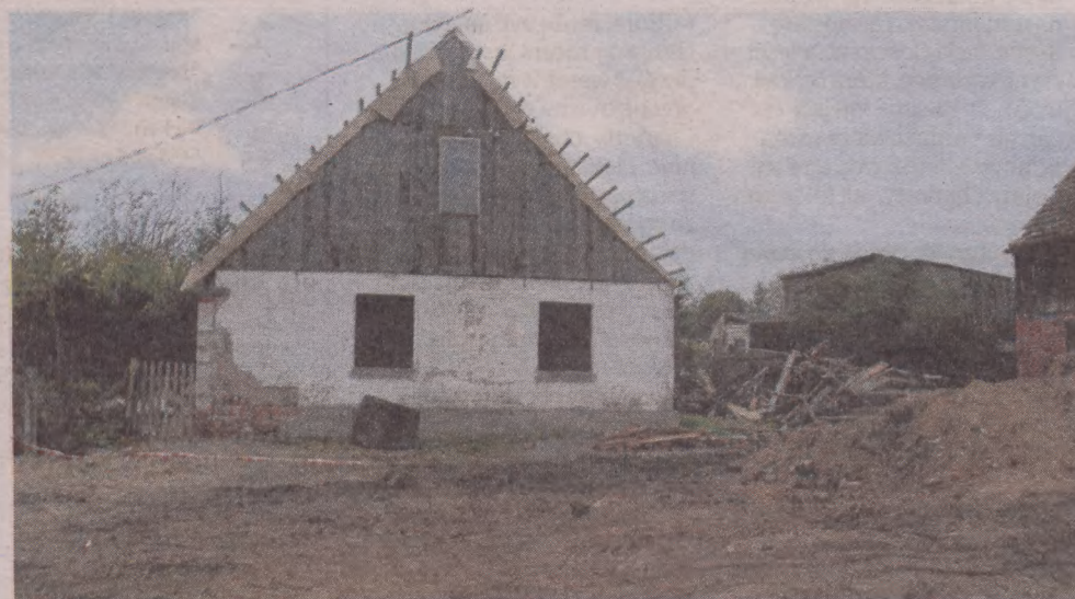
► Tak wyglądał obecny dom Twardowskich, gdy był jeszcze ruiną. Teraz rodzina powoli porządkuje otoczenie i przygotowuje się do budowy płotu
