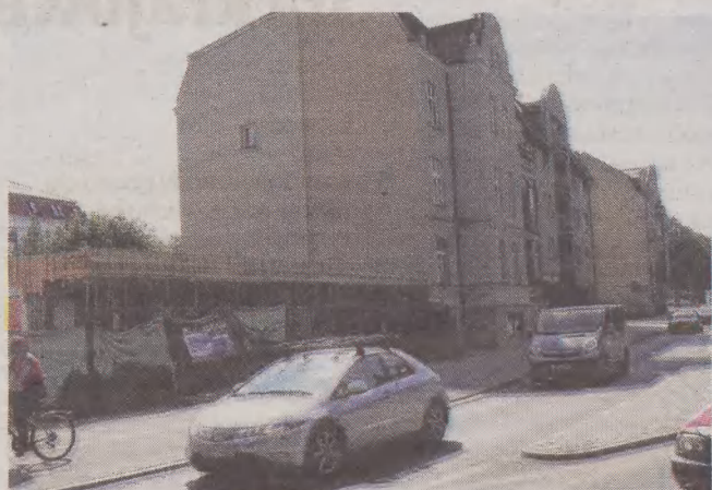
Prowadzone budowy przy ul. Kopernika są dobrze odgródzone od chodnika. Można obok nich chodzić bezpiecznie
