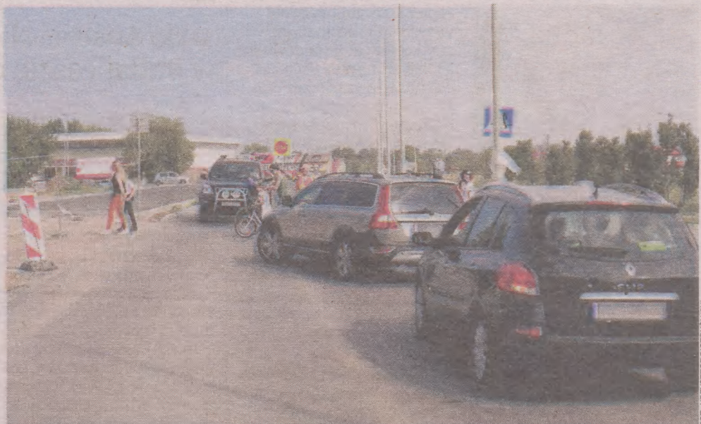
Przejście na ul. 11 Listopada, w pobliżu Szkoły Podstawowej nr 10, jest wyjątkowo niebezpieczne. Cały czas trwają tam prace przy budowie ringu. Na bezpieczeństwie dzieci czuwa anioł
