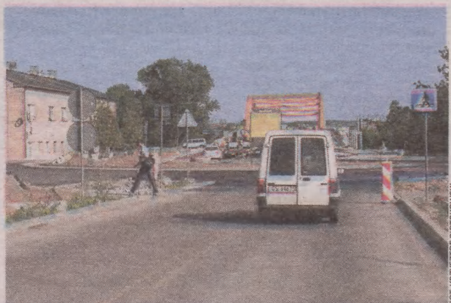
Prace na pierwszym etapie budowy ringu finiszują. Dziś drogowcy będą układać tam ostatnią warstwę asfaltu
