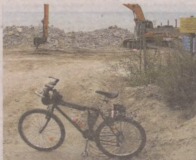
► Żurawie pierzaste szykują się do odlotu, a te mechaniczno-hydrauliczne pewnie przetrzymują na ustekiej plaży
