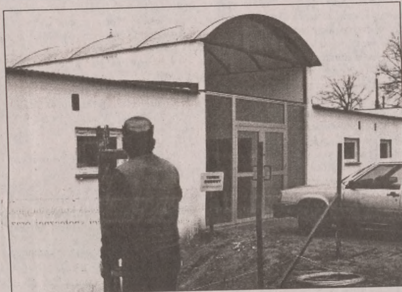
Żeliwna konstrukcja płotu jest już wkopana w ziemię
