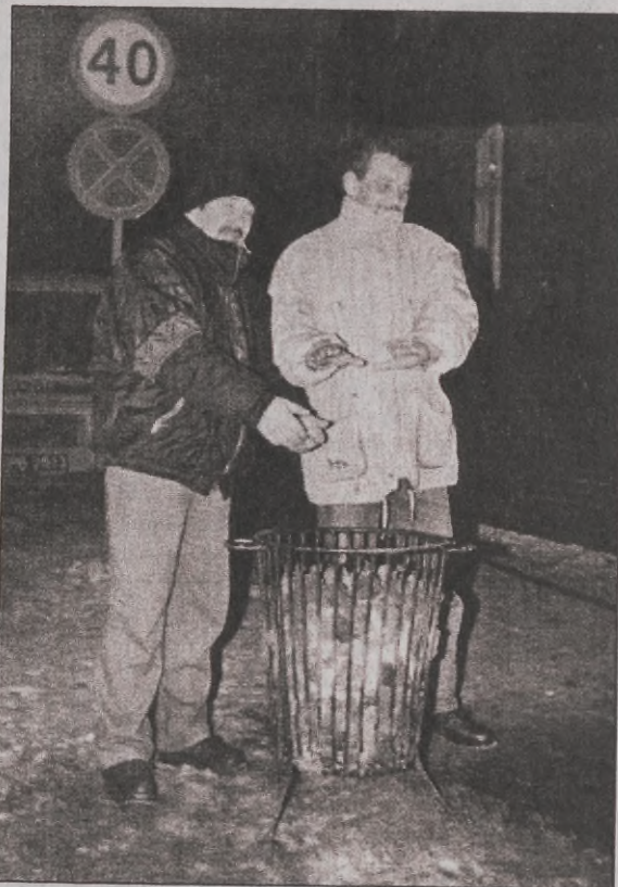
Podczas usuwania awarii pracownicy łączności ze słupskiego węzła PKP wystawili na ul. Kołtąją koksownik
