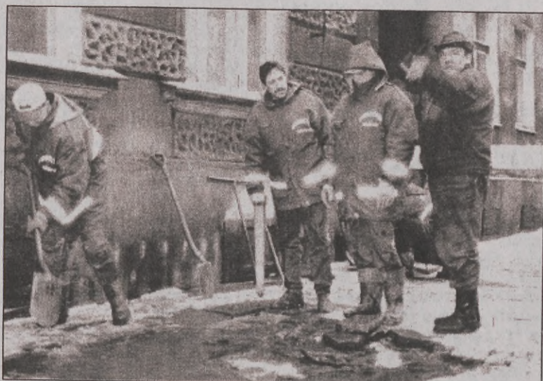
Gorzej miała ekipa ze słupskich „Wodociągów” naprawiająca pękniętą rurę wodociągową na ul. Prusa. Nie dość, że zimno, to jeszcze mokro...
