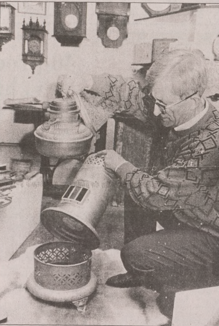
To był stary żardzewiały piecyk. Sam go skrócił, wyczyścił i pomalował. Po podniesieniu czapki można nalać nafty i podpalić. Piecyk był używany przed wieloma laty. Podobne zastosowanie mają obecne – gazowe.
