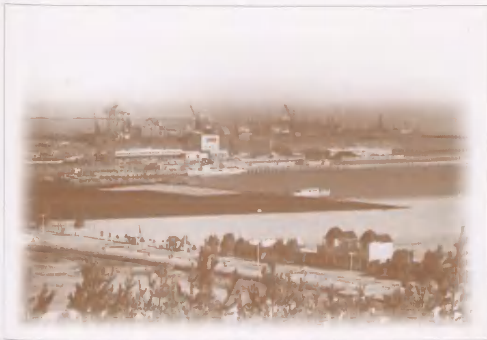
38. Panorama portu z Kamiennej Góry, 1935r., refulowanie terenów pod Molo Południowe.
