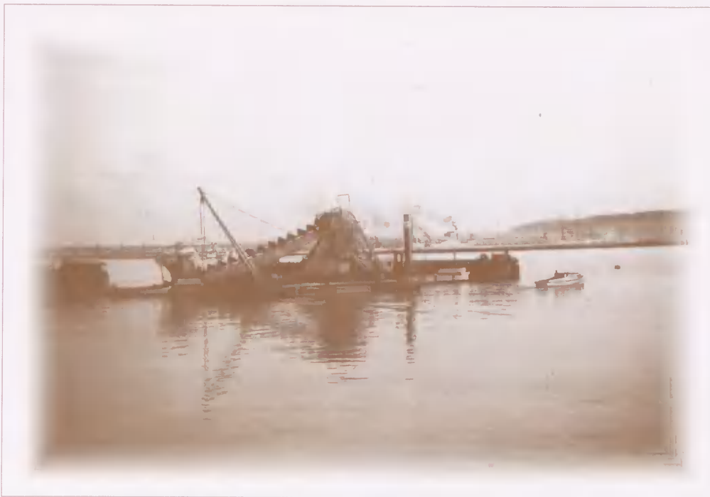
87. Pogłębiarka kublowa w Kanale Przemysłowym, 1935r.
