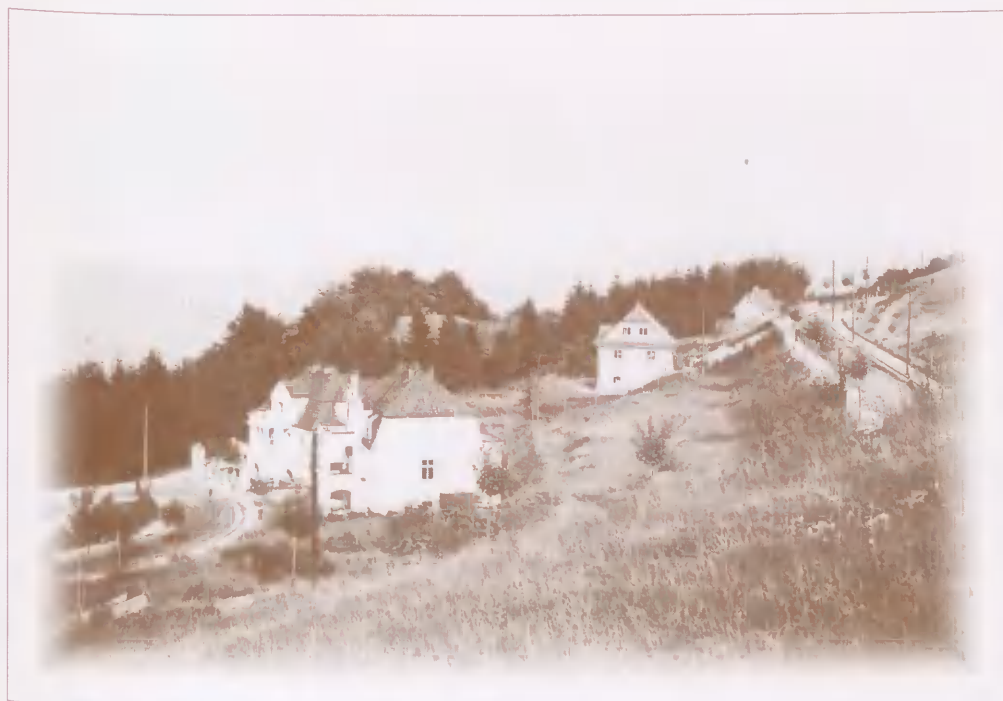
31. Widok na Kamienną Górę i morze, 1930r.
