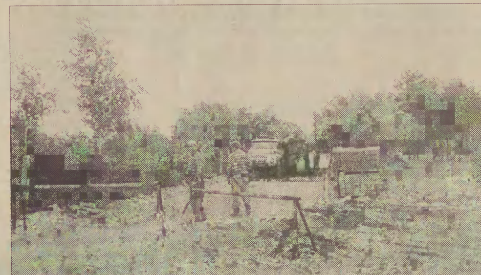
Przygotowania do kładzenia kostki na trakcie pieszo - rowerowym od ul. Jana Pawła II do Brzeźna. Można już spacerować w kierunku Gdańska Jelitkowa. Fot. Kazimierz Netka
