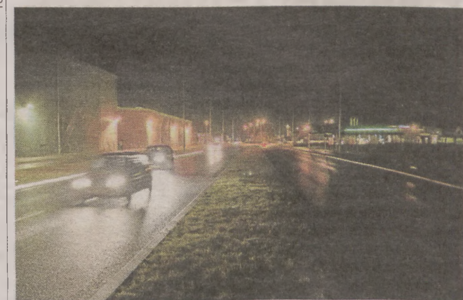
► Kolejna usterka na ringu. Nie działa część lamp oświetleniowych. Zostaną naprawione w ramach gwarancji
