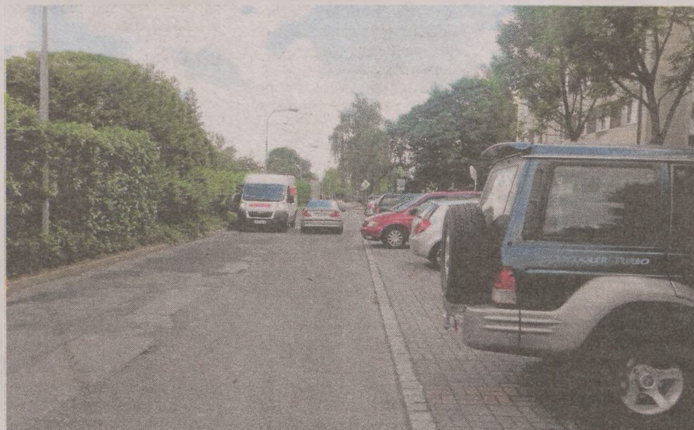
► Zarząd Infrastruktury Miejskiej sprawdzi wykonanie prac drogowych na ul. Wiatracznej. Jeśli stwierdzi uchybienia, wezwie wykonawcę do naprawy stanu jezdni
