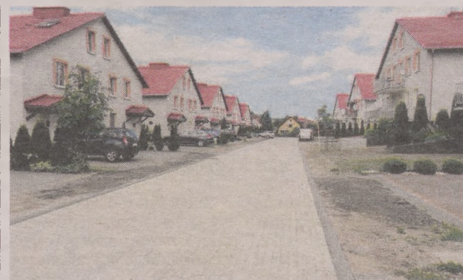
► W terminie zakończono przebudowę ulicy Naruszewicza w Bytowie. Wykonawcą robót było Przedsiębiorstwo Budowlano-Produkcyjno-Usługowo-Handlowe Roman Jercezek (zida)
