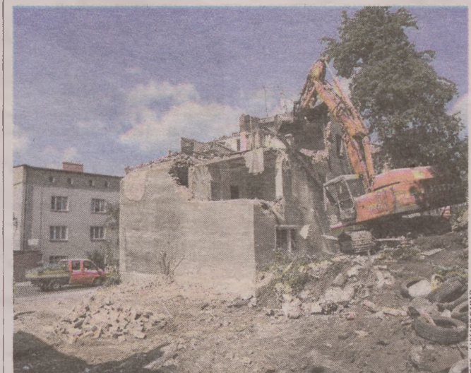
► Trwa rozbiórka kamienicy przy ul. św. Piotra. Niedługo działka będzie przygotowana do ponownego zagospodarowania
