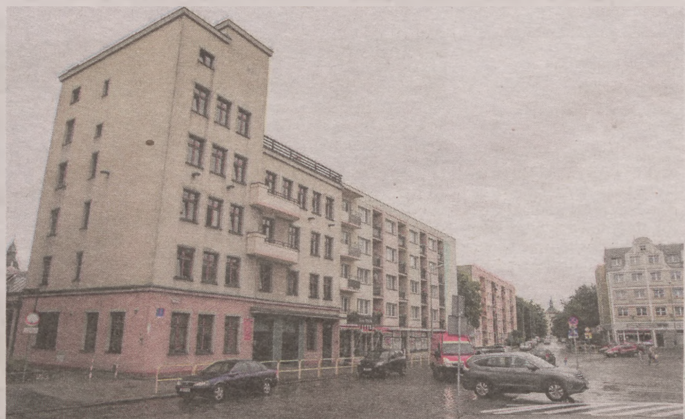
► Gdy się dobrze przyjrzymy, to na sądowym budynku jeszcze widać ślad po dawnej lokalizacji jeszcze niemieckiego zegara
