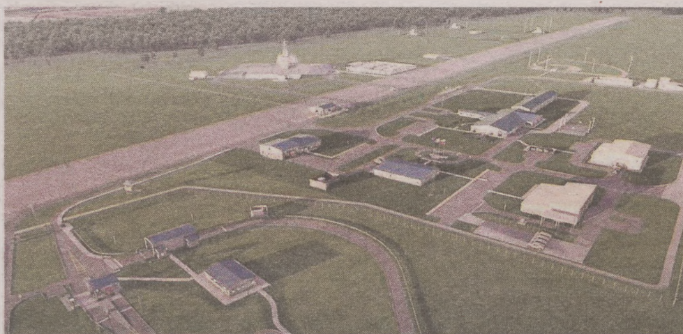
► Turecka firma ma w kontrakcie budowę całego zaplecza socjalnego, dróg, parkingów, obiektów socjalnych, boiska do bejsbola, punktu medycznego czy straży pożarnej
