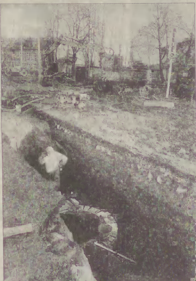
Na ul. Wypiańskiego we Wrzeszczu widać prace. W przyszłym roku roboty modernizacyjne obejmą sąsiadujące z ulicą najbardziej kolizyjnie skrzyżowanie w Gdańsku.
