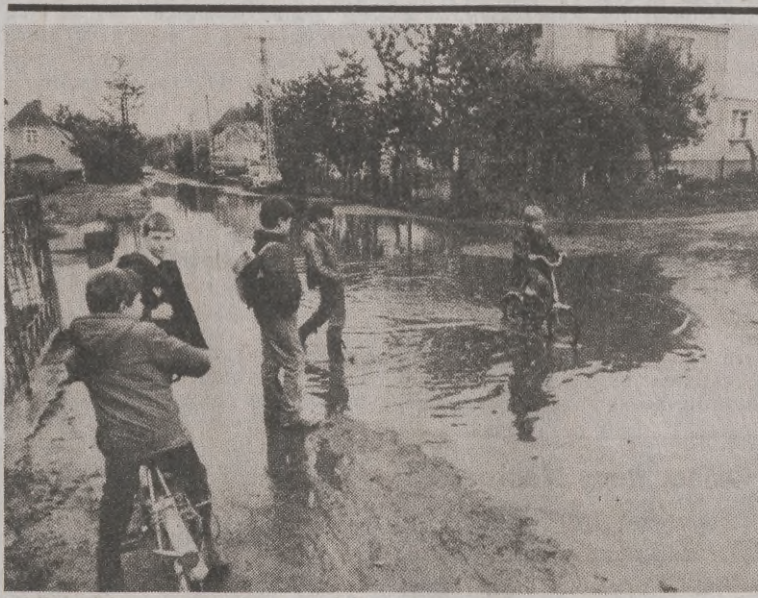
Ulica Zielona w Koszalinie mogłaby od dawna nazywać się też wodną. Uszkodzona kanalizacja spowodowała, że cała jezdnia jest permanentnie zalana wodami miedzyrzecznymi. O przebiegu tam suchą nogą nie ma mowy. A przecież ta ulica codziennie musi chłodzić do szkoły dzieci a dorodzi do pracy. Jak nas poinformowali mieszkańcy tej ulicy interwencje u odpowiednich władz nie przyniosły efektu. Nikt nas nie chce zrozumieć — mówi, a dla nas jest to tragedia. Jak wyglądała ta ulica wczoraj zarejestrował nasz fotoreporter, Jerzy Patan. (pat)
